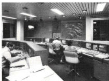
Afb. 11. Kijkje in het hoofdbureau van politie in Koblenz. In de rechter lessenaars zijn de beeldschermen voor surveillance-begeleiding ondergebracht, alsmede de mobilifoons en het noodoproep-systeem. De linker lessenaar bevat eveneens een mobilifoonsysteem waarmee alle mobiele posten tegelijkertijd kunnen worden opgeroepen.
