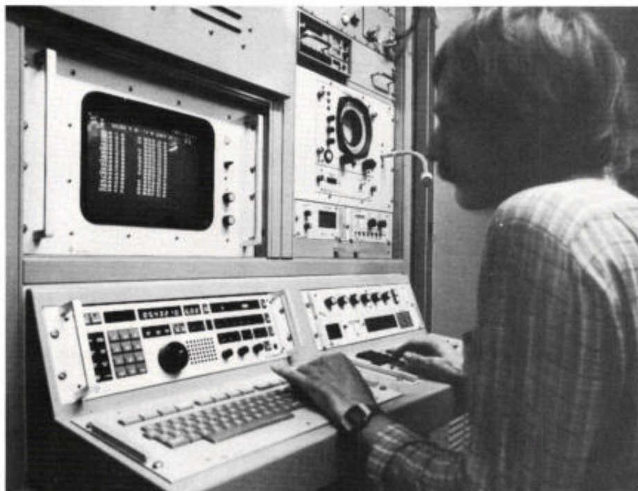
Afb. 3. Automatisch bestuurd inrichting voor kortegolfontvangst.
